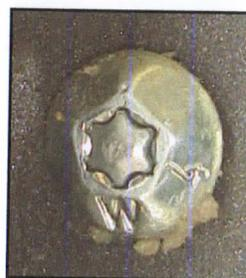
Fissaggio con viti di sicurezza in acciaio zincato, per la protezione da furti, vandalismi e manomissioni.
